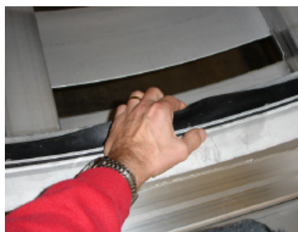
Figur 7.6 Inloppsgummitätning
