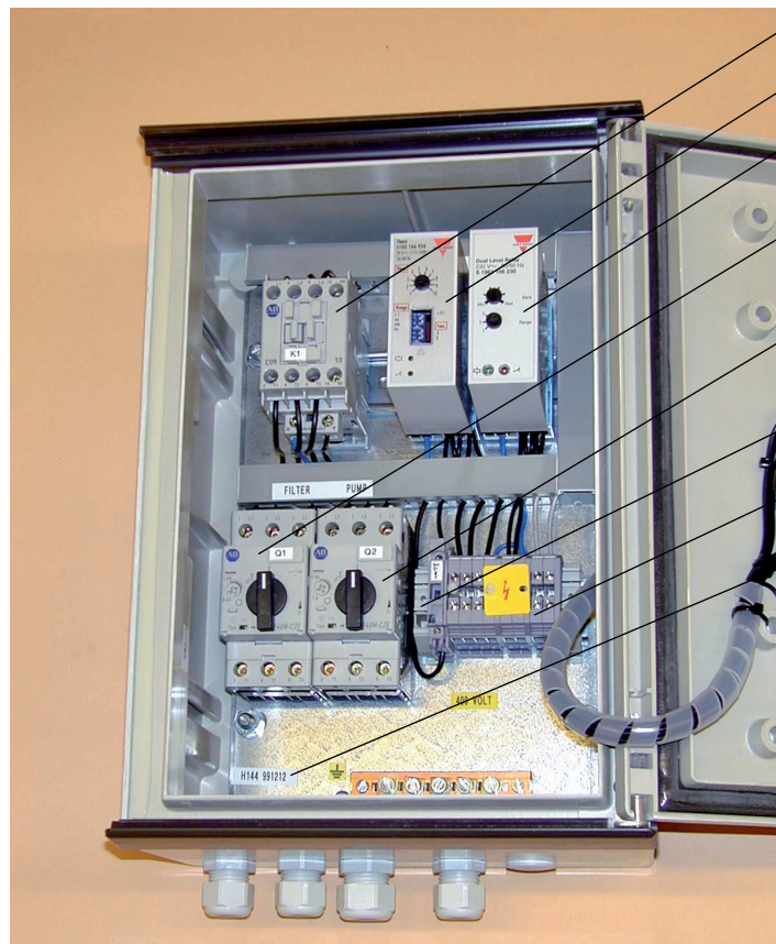
Figura 5.2 Armario de control estándar Hydrotech (opcional)
