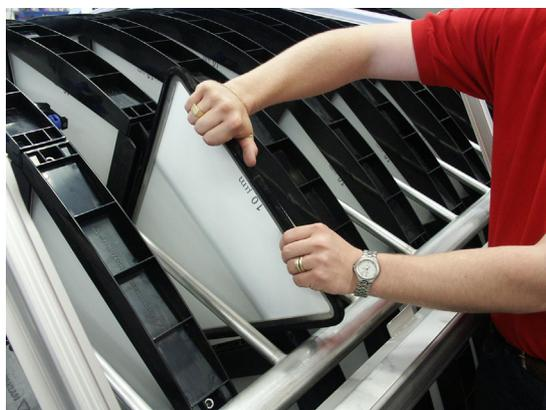
**Figure 7.12** Le panneau filtrant est retiré.
