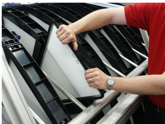
**Figure 7.13** Le panneau filtrant est retiré.
