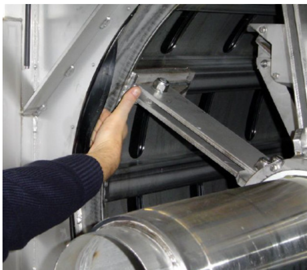
Figur 6.31 Kontroll av inloppstätningen.
