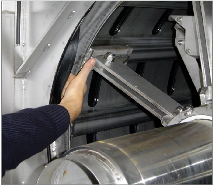
Figur 6.20 Kontroll av inloppstätningen.
