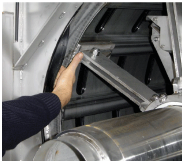
Figur 7.31 Kontroll av inloppstätningen.
